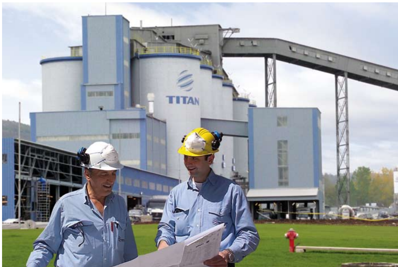
Εργοστάσιο Zlatna Panega, Βουλγαρία
