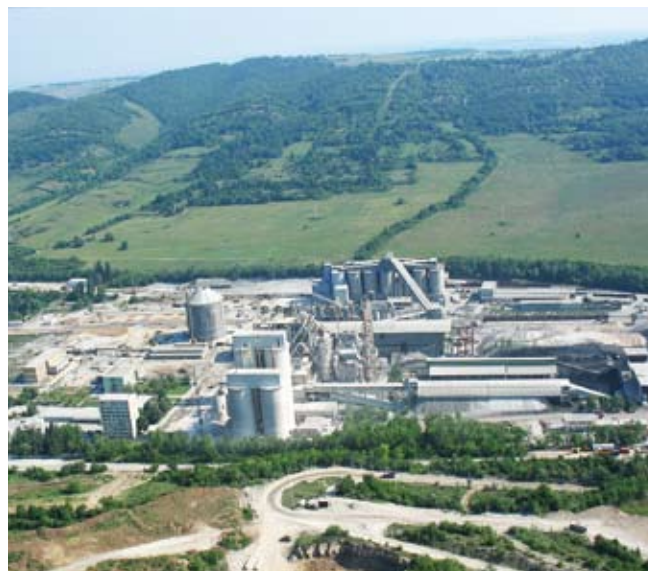
Εργοστάσιο Zlatna Panega, Βουλγαρία
