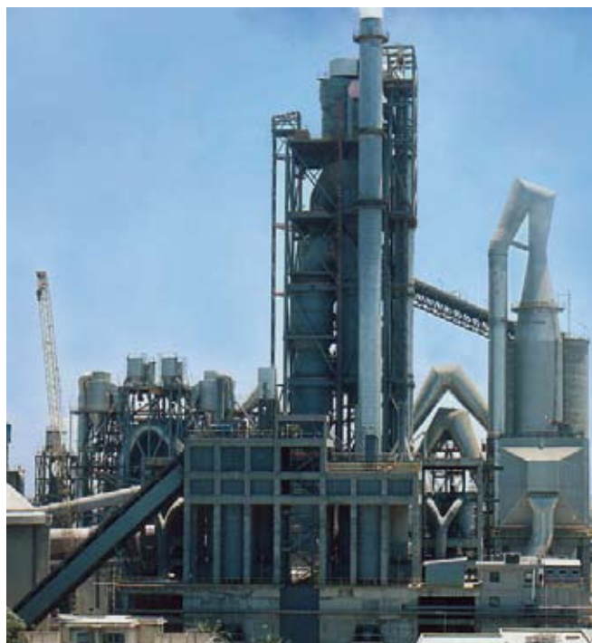
Εργοστάσιο Αλεξάνδρειας, Αίγυπτος
