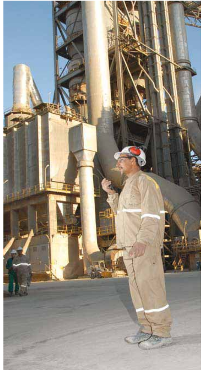
Εργοστάσιο Αλεξάνδρειας, Αίγυπτος
