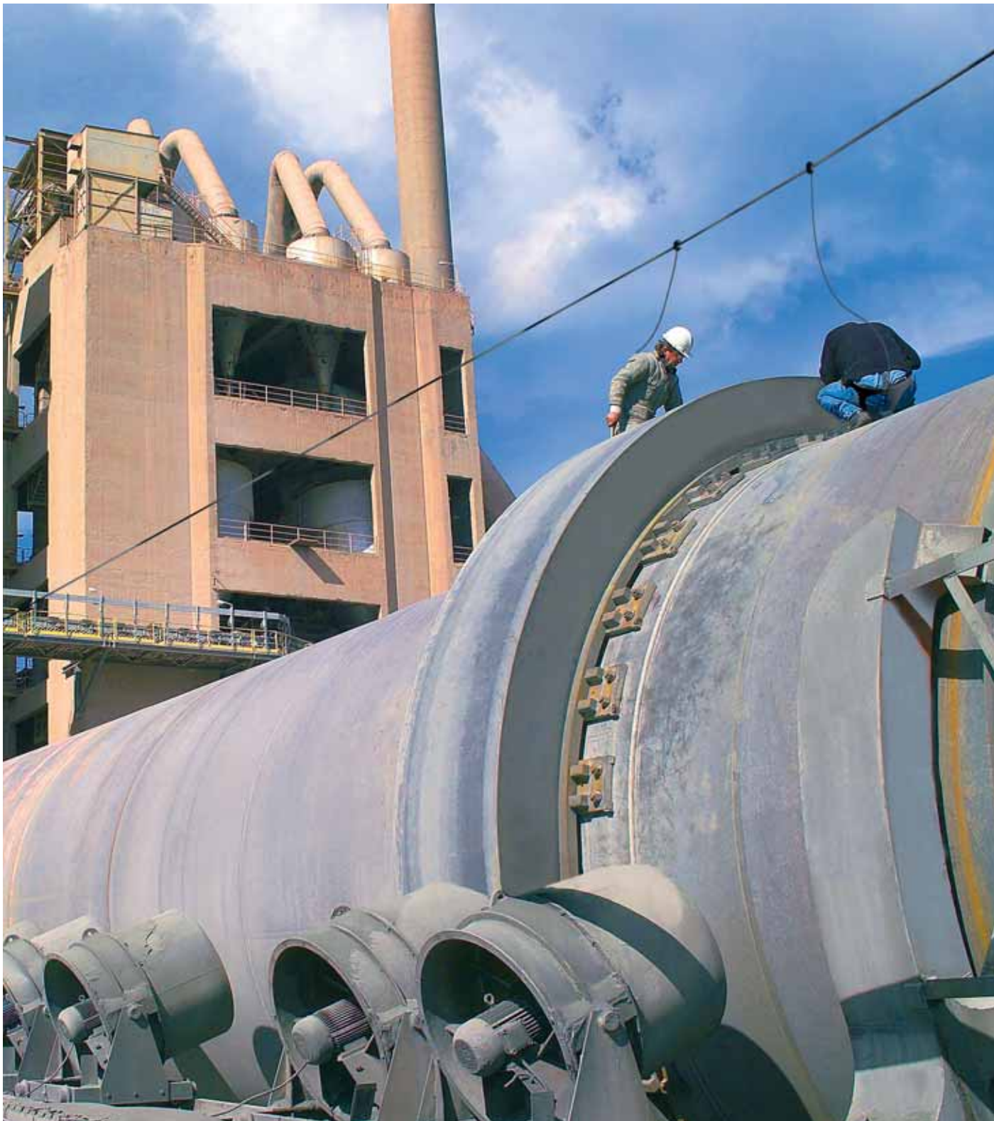
Εργοστάσιο Καμαρίου Βοιωτίας
