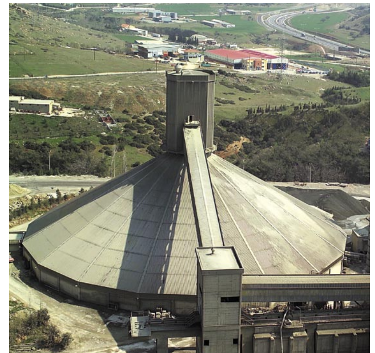
Αποθήκη κλίνκερ στο εργοστάσιο Ευκαρπίας Θεσσαλονίκης
