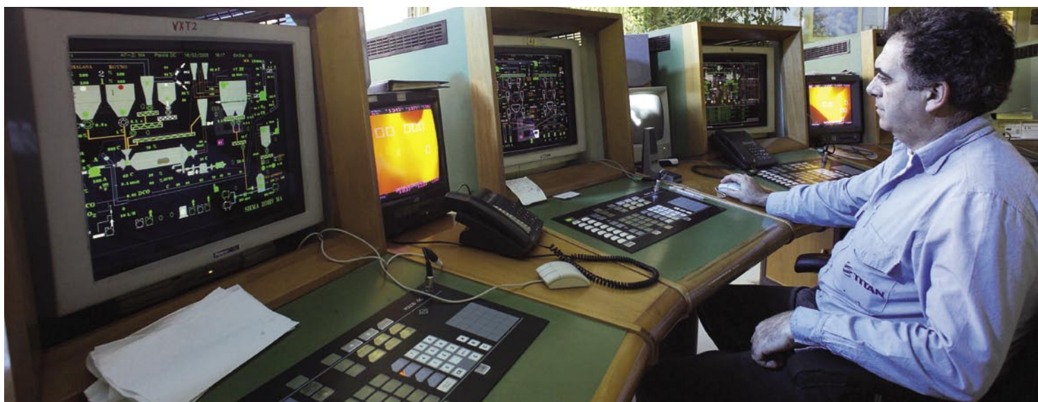
Οθόνες ελέγχου στο εργοστάσιο Δρεπάνου Αχαΐας
