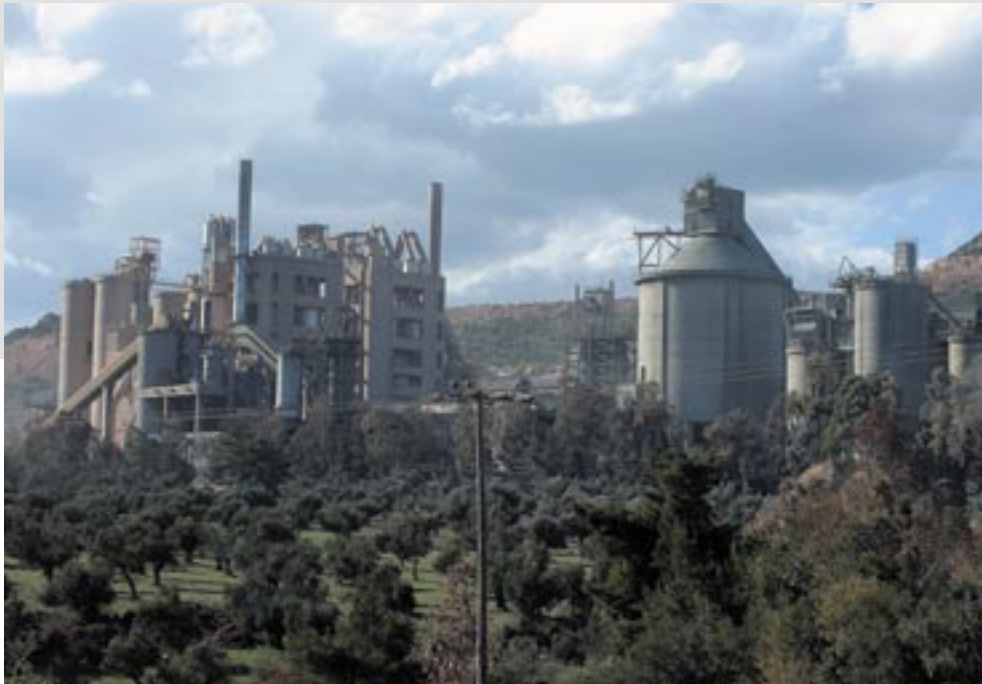
Εργοστάσιο Καμαρίου, Βοιωτία
