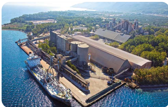
Εργοστάσιο τσιμέντου Πάτρας, Ελλάδα
