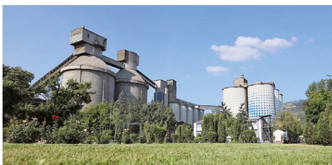
Εργοστάσιο τσιμέντου Usje, Β. Μακεδονία
