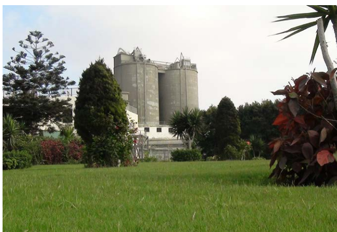
Cimenterie de Alexandria, Égypte
