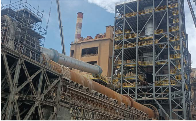
Unité de pré-calcination dans l'usine de Kamari, Grèce
