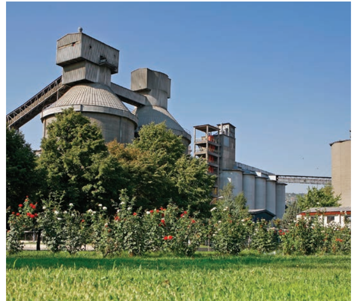
Εργοστάσιο τσιμέντου Usje, Βόρεια Μακεδονία
