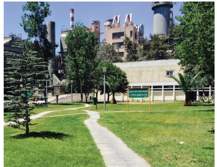
Εργοστάσιο τσιμέντου Καμαρίου, Ελλάδα
