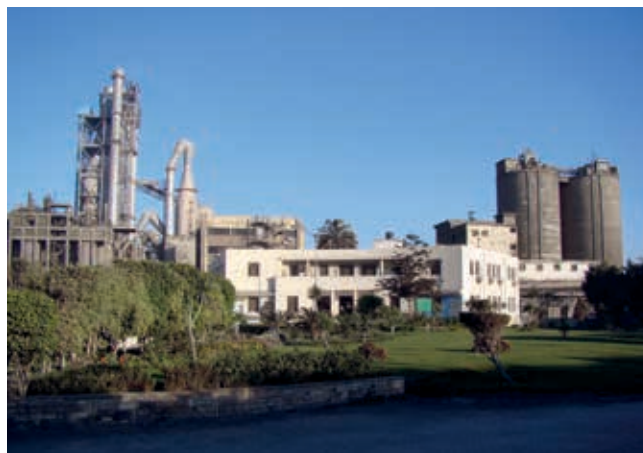
Εργοστάσιο τσιμέντου Alexandria, Αίγυπτος
