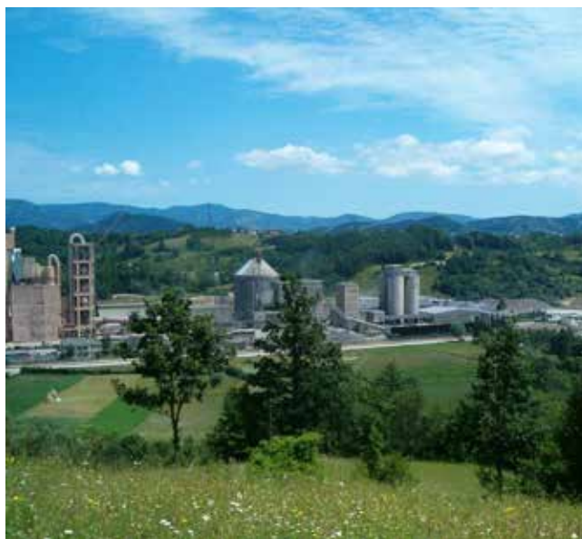
Εργοστάσιο τσιμέντου Kosjeric, Σερβία
