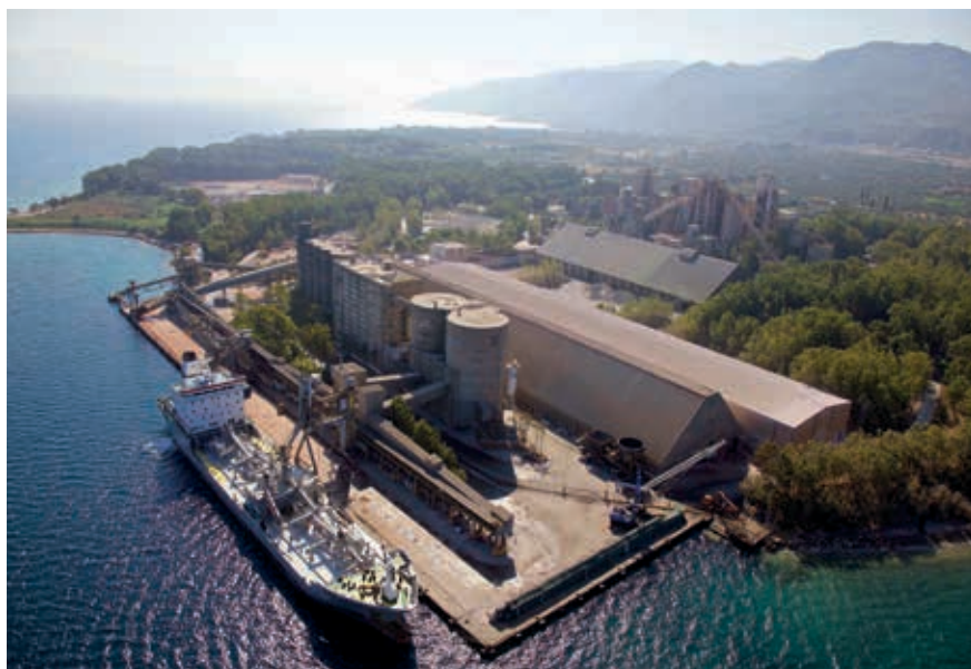
Εργοστάσιο τσιμέντου Πάτρας, Ελλάδα
